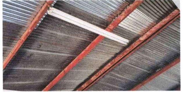
Foto 2: MANTENIMIENTO DE ESTRUCTURA
