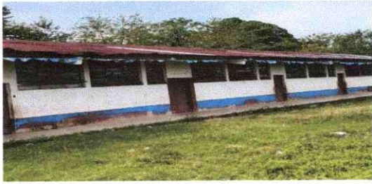
Foto1: CAMBIO DE LAMINA
